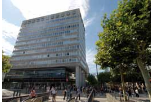
Revitalisiertes Bürogebäude Bienenkorbhaus
