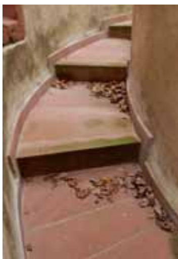
Innensanierung der Galluswarte
