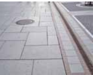
Bodenbelag im Übergangsbereich zwischen Kleinpflaster und Großplatten
