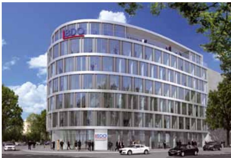
Bürostandort Hanauer Landstraße 115: Neubau BDO Wirtschaftsprüfungsgesellschaft, © Lang & Cie. Frankfurt a. M.
