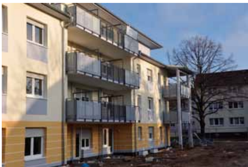
Starterzeile 2 kurz vor der Fertigstellung
