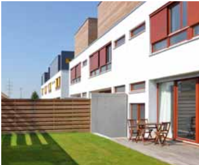
Bauherrengruppe Altkönigblick © Leber-Architekten
