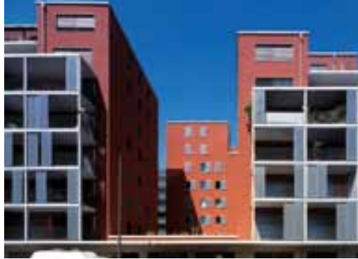
Wohnungsneubau im Bahnhofsviertel, Wilhelm-Leuschner-Straße (Büro Scheffler und Partner, Frankfurt)
