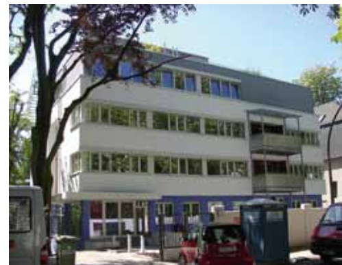
Abb. 9 Bürogebäude mit neuer Nutzung, Holzhausenstraße Foto: naumann Architekten
