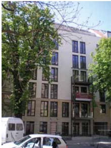
Abb. 14 Corneliusstraße 9, Straßenansicht neu
