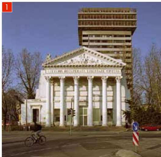
Portal vor dem Wiederaufbau
