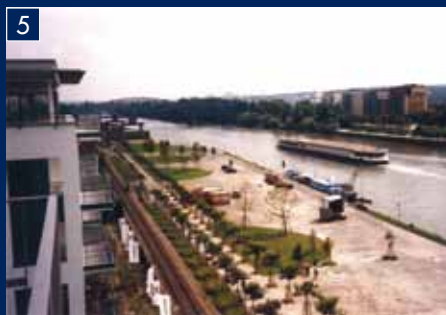
5 Neue Wohnbebauung mit Blick auf Weseler Werft und Main
