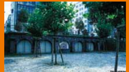
Detail am Tiefkai: Flächenversiegelung
