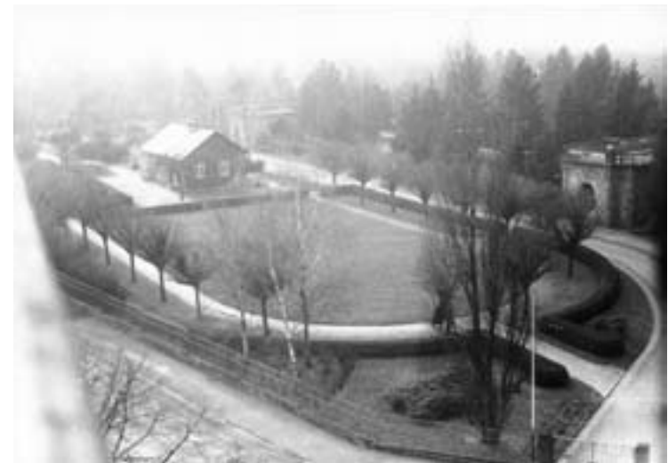
Wasserwerk Darmstädter Landstrasse/Boehlepark, 1934; © Institut für Stadtgeschichte
