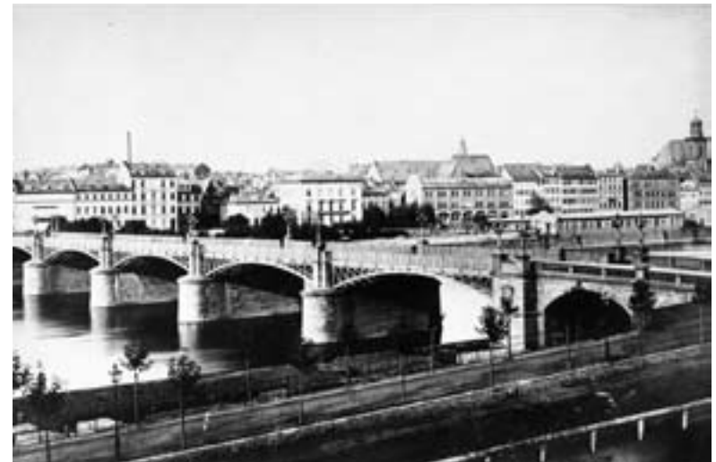
Untermainbrücke, 1878; © Dr. Meyer-Wegelin
