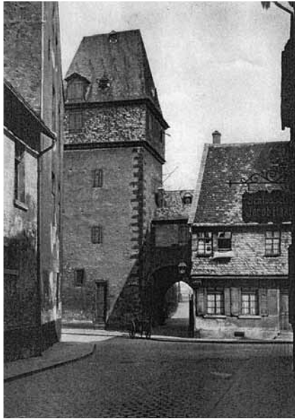
Der Kuhhirtenturm vor dem Umbau, Lichtdruck nach einem Foto von Paul Wolff, 1923 © Institut für Stadtgeschichte
