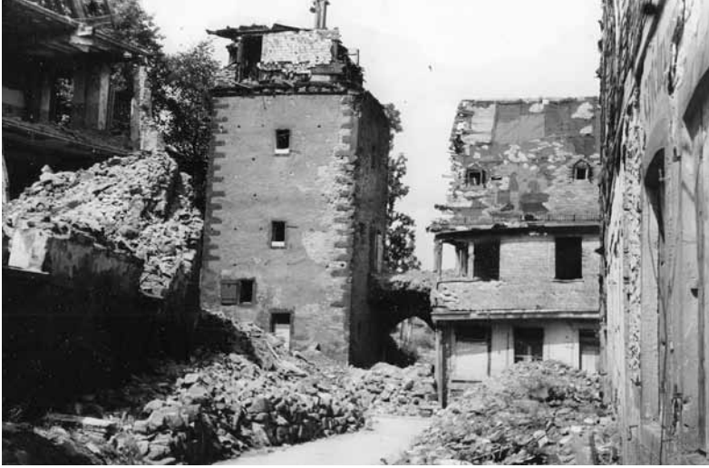
Abb. oben: Das Quartier um den Turm wurde bei einem Bombenangriff im Oktober 1943 schwer beschädigt, Fotografie von Heinrich Stürtz, 1943 © Institut für Stadtgeschichte
