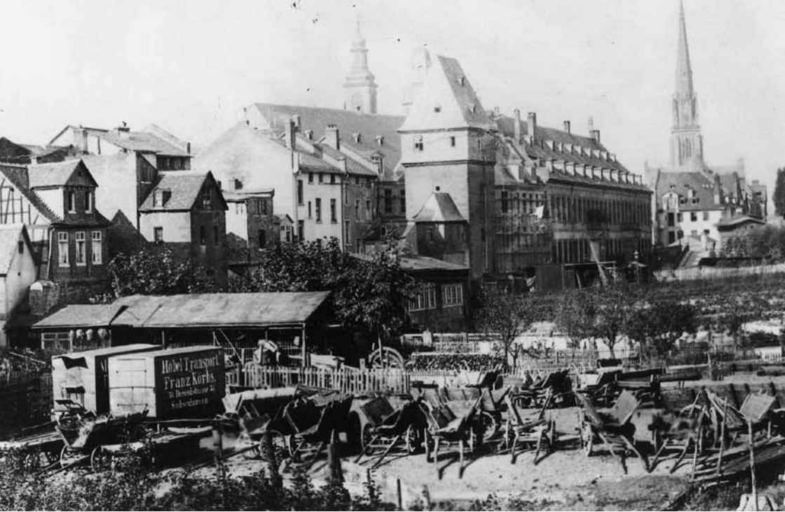
Abb. oben: Der Deutscherhain mit Schuppen und Remisen am Uferstreifen, Fotografie von 1897 © Historisches Museum Frankfurt
