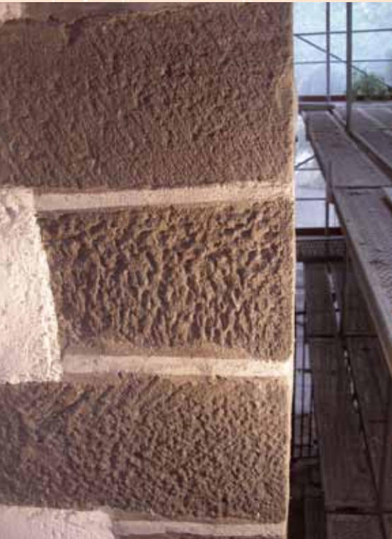
Nordostseite des Kuhhirtenturms mit Eckquadern, die mit unterschiedlichen Werkzeugen bearbeitet wurden und damit den Übergang zweier Bauphasen dokumentieren, Fotografie von Ulrike Schubert, Frankfurt am Main, 2010
