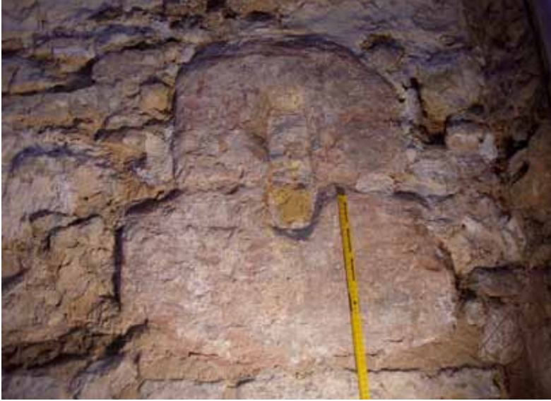
Westseite des Kuhhirtenturms mit ehemaliger vermauerter Schießcharte, letztes Viertel des 14. Jahrhunderts, Fotografie von Ulrike Schubert, Frankfurt am Main, 2010
