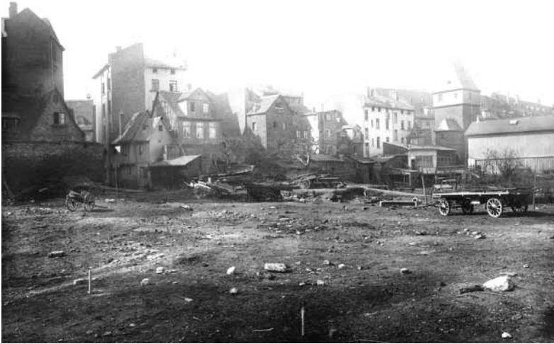
Der Deutschherrnkai mit herausgeschobenem Mainufer und Resten der alten Stadtbefestigung, Fotografie von Gottfried Vömel, 1903 © Institut für Stadtgeschichte
