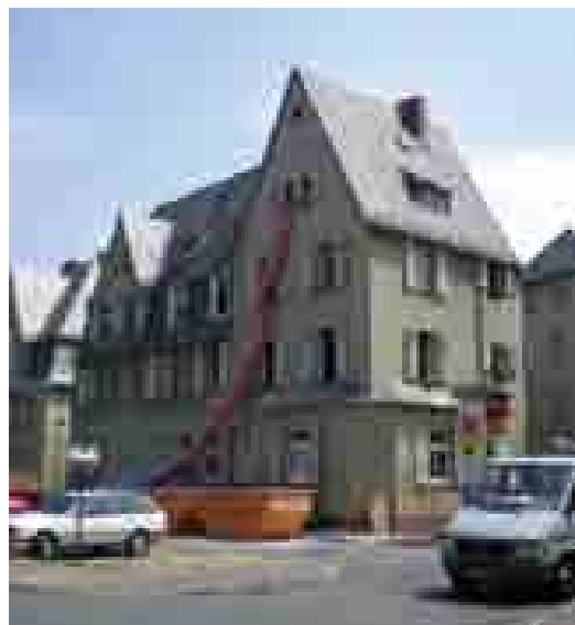
Roscherstraße 1 im Bau
