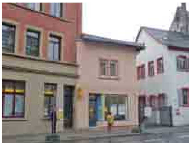
Das neue Modernisierungsberatungsbüro in Höchst, Bolongarstraße 135
