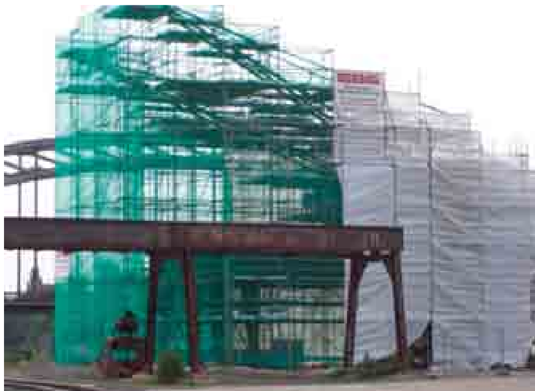
Instandsetzung der beiden Hafenkräne auf der Ruhrorter Werft
